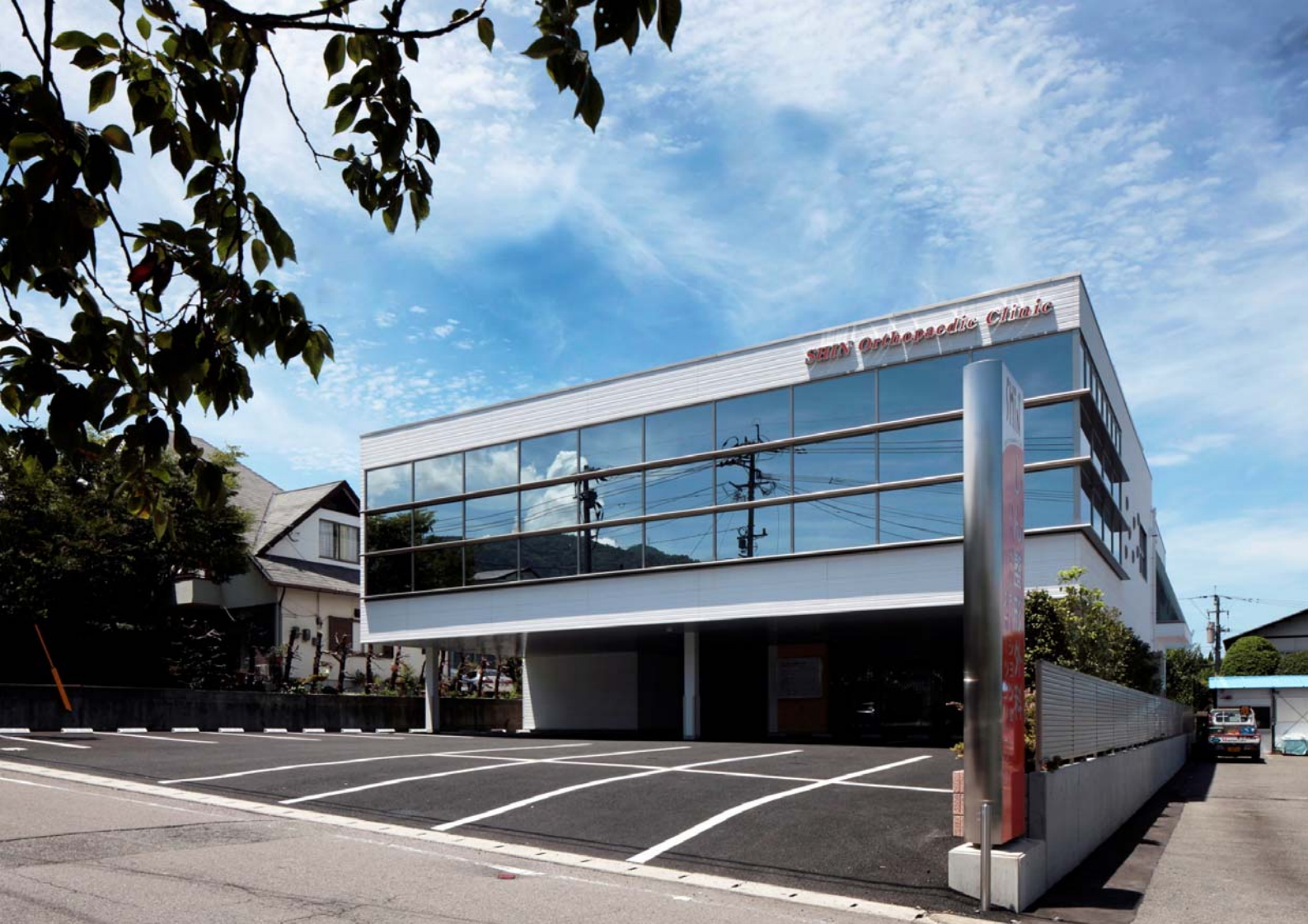
直線構成されたモダンな外観。全面ガラスカーテンウォールが、地域への存在感をアピールしています。
